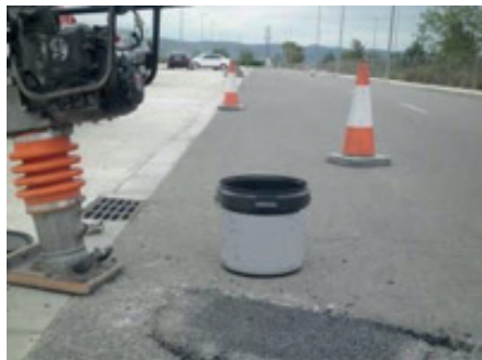
VERTER EL PRODUCTO Y COMPACTAR
