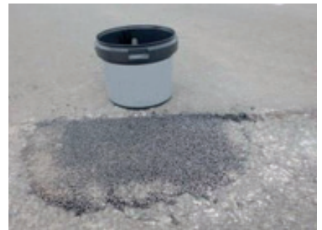
ACABADO FINAL PUESTA EN SERVICIO DE LA CARRETERA
